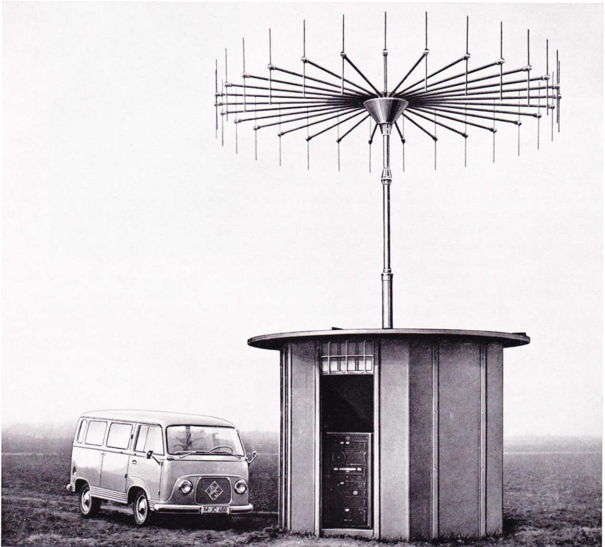
Abb. 1 Großbasisantenne und Peilhaus einer Sichtpeilanlage NP 4
